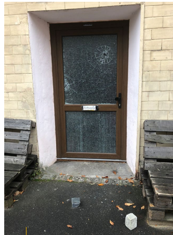
Im Herbst 2019 häuften sich in Amberg Übergriffe auf die „Hutfabrik“, teilweise wurden dabei die Insignien der „Identitären Bewegung“ hinterlassen
