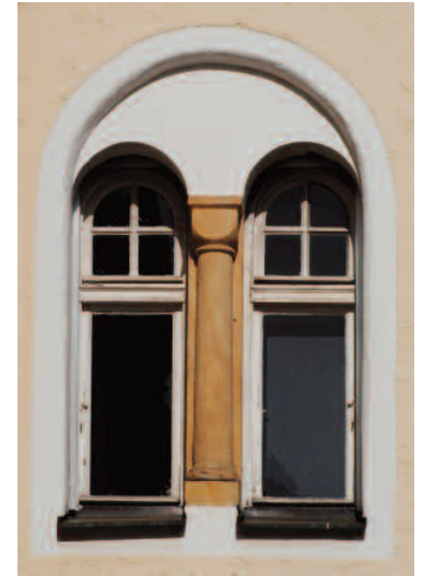
Gekoppelte Rundbogenfenster des Gemeindezentrums
